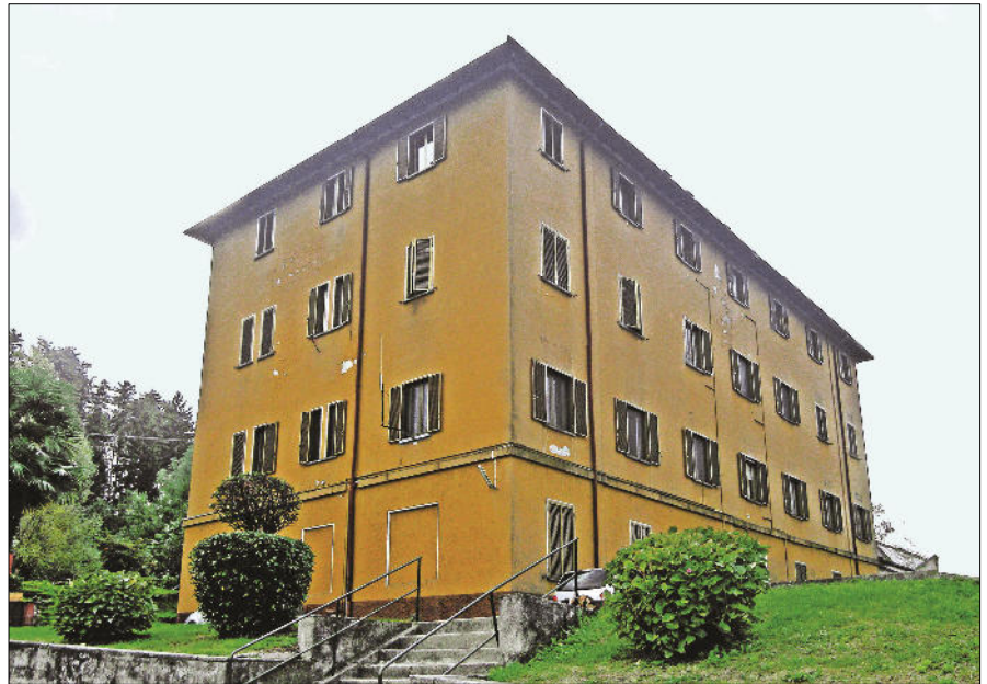
L'edificio della ditta Stehli sede dell'ospedale territoriale di Germignaga
